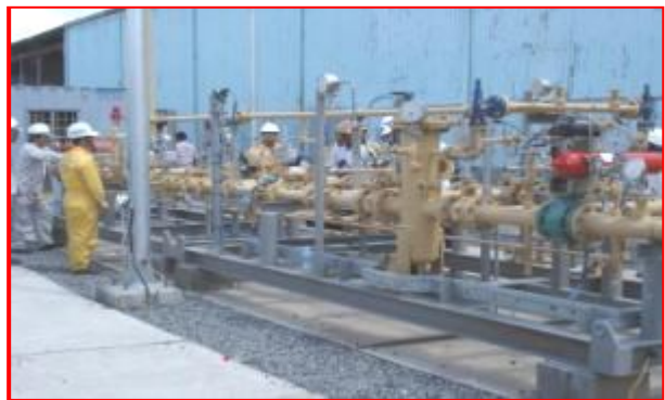
Thi công lắp đặt hệ thống ống công nghệ trạm cấp khí Thấp áp cho nhà máy gạch Hoàng Gia
