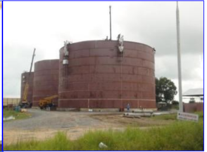
Chế tạo, lắp đặt bồn chứa xăng dầu 10.000m 3 (B11, B12, B13) - Tổng kho xăng dầu Nhà Bè
