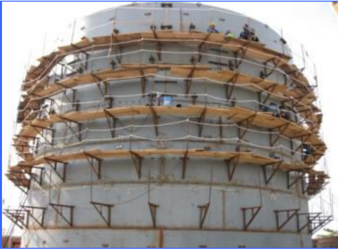
Chế tạo, lắp đặt bồn chứa nước PCCC - Kho chứa LPG Gò Dầu
