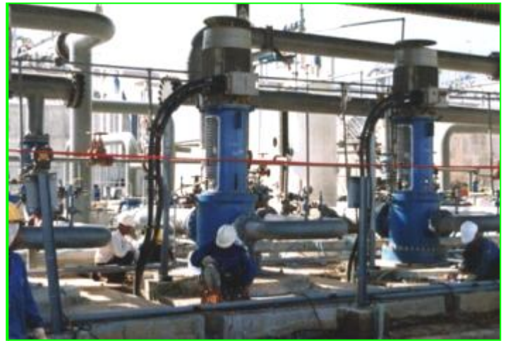
Lắp đặt hệ thống điện điều khiển và trạm bơm Công trình: Đường ống, Kho chứa Cảng Thị Vải
