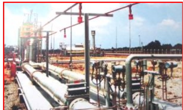
Dự án : Thiết kế, thi công , lắp đặt trạm phân phối khí Bà Rịa
