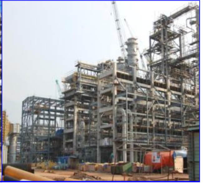
Chế tạo và lắp đặt hệ thống giá đỡ ống và thiết bị tại nhà máy lọc dầu Dung Quất
