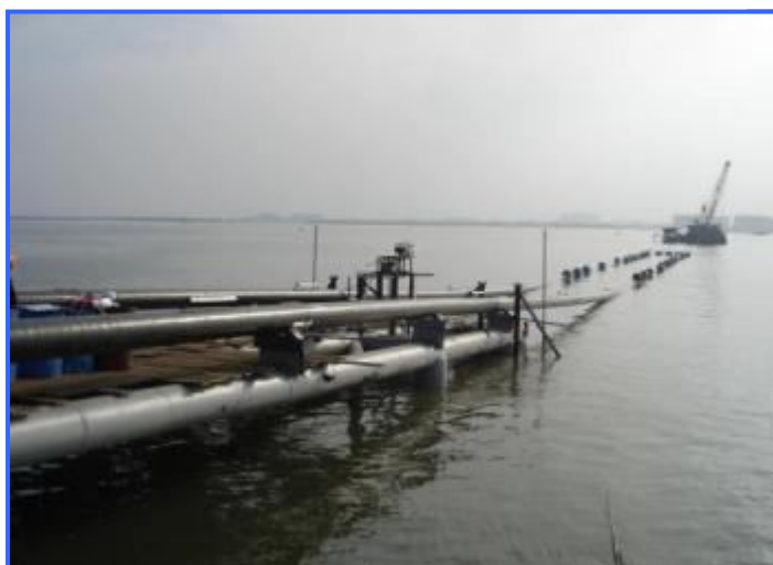
Thi công rải ống xuống biển từ sà lan -Kho xăng dầu Cù Lao Tào
