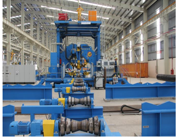
Xây dựng Nhà máy chế tạo ống thép hàn thẳng tại KCN Dịch vụ Dầu khí Soài Rạp – Tiền Giang
