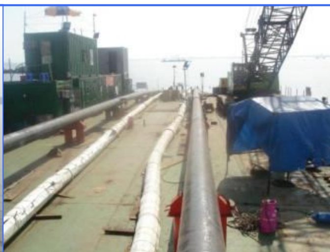
Thi công rải ống xuống biển từ sà lan -Kho xăng dầu Cù Lao Tào
