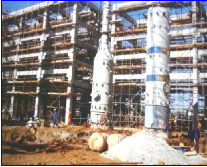
Chế tạo hệ thống móng, thiết bị tại nhà máy lọc dầu Dung Quất
